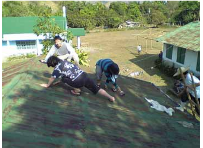
(聖デービッド教会牧師館屋根のペンキ塗り)
